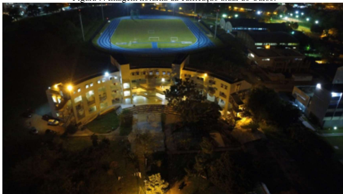
Figura 9. Imagem noturna da edificação atual do Curso.
