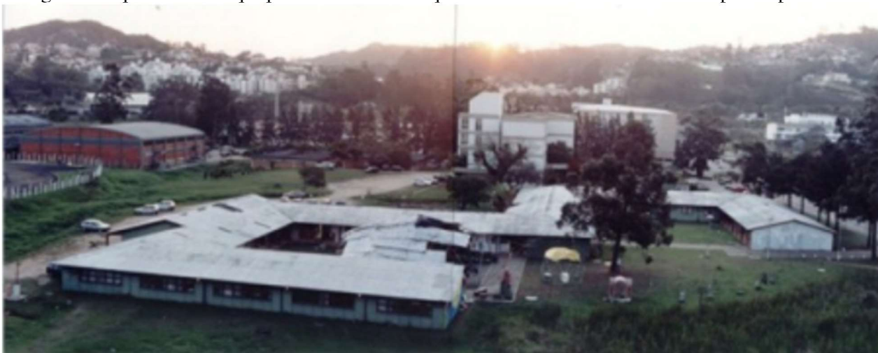
Figura 6. A primeira sede própria do Curso de Arquitetura e Urbanismo da UFSC: o prédio provisório.
