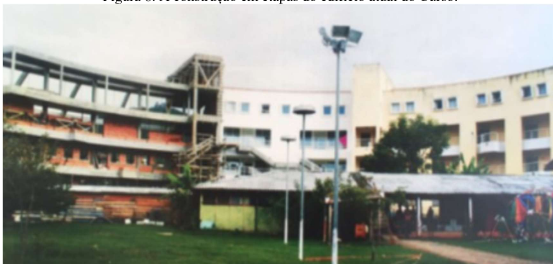
Figura 8. A construção em etapas do edifício atual do Curso.
